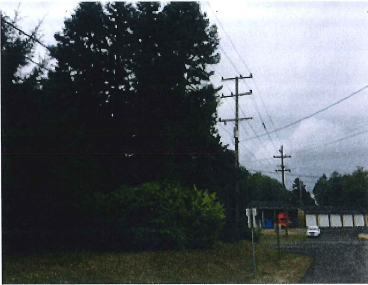
SE Jetty Looking North to Mini Storage
